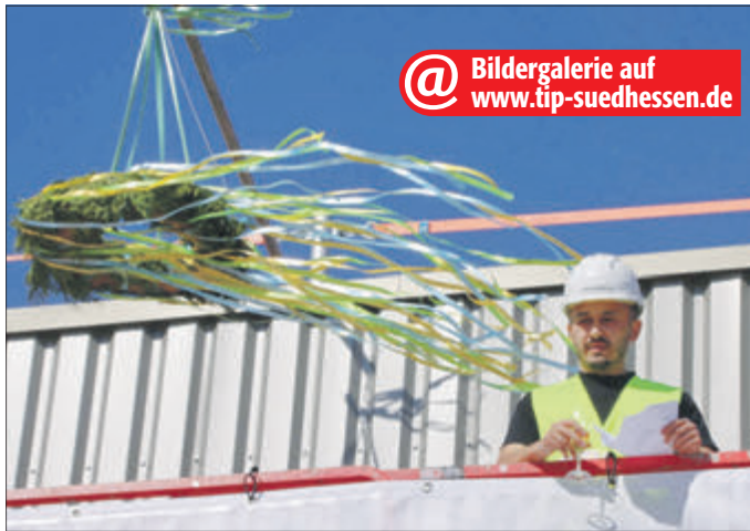
Blick auf die Halle. Bauleiter Onur Kuzören warf nach dem Richtspruch das Trinkglas nach altem Brauch nach unten. Foto: Hannelore Nowacki
