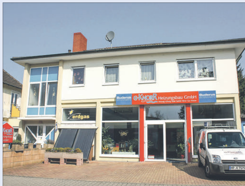
G. Knorr Heizungsbau GmbH ist Ansprechpartner für Bäder und Heizungstechnik, Sonnenthermie und Wartung. Badzubehör wie Armaturen, Brauseköpfe und vieles mehr ist auch im Ladenverkauf bei Knorr Heizungsbau erhältlich oder kurzfristig lieferbar. Foto: Hannelore Nowacki
