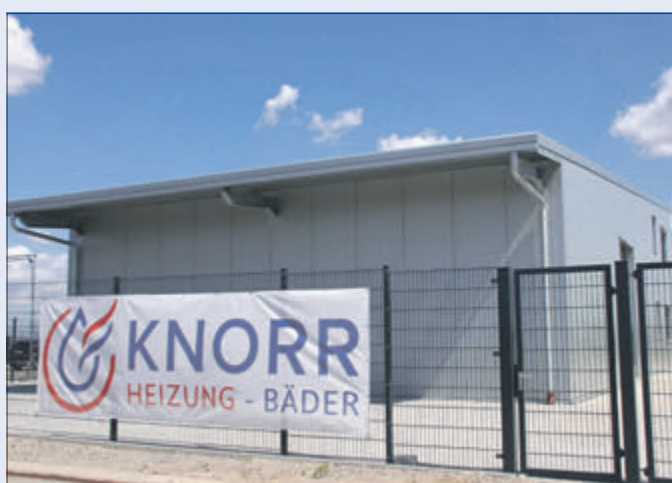
Neuer Knorr-Firmensitz im Bau – mehr Platz für Parkplätze, Büros, Werkstatt und Lager. Neu gestaltet ist das Logo. Foto: Hannelore Nowacki
