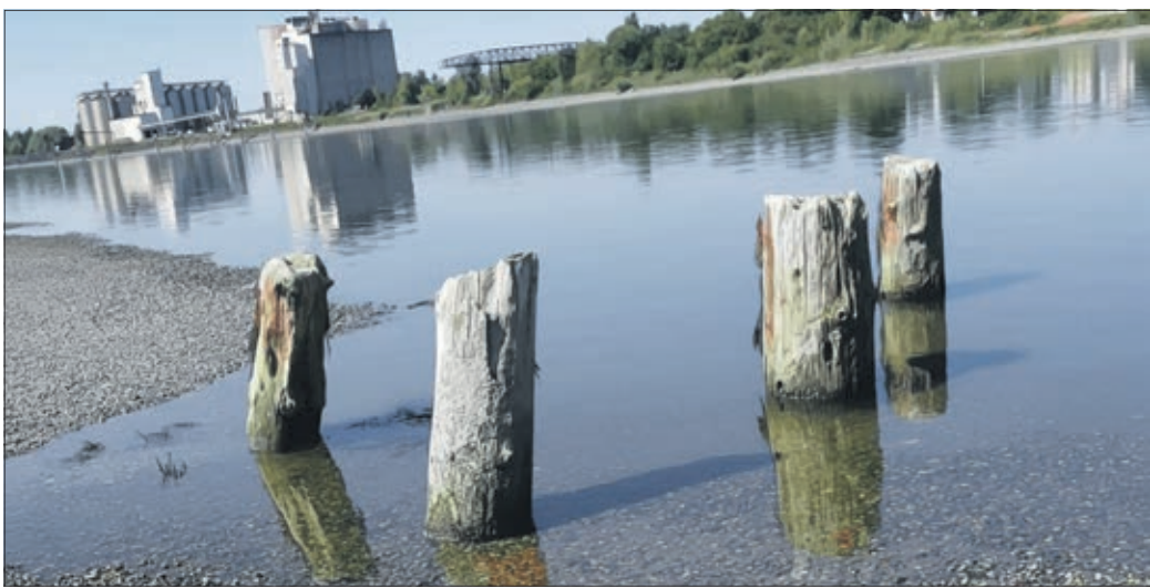
Aufgrund des Niedrigwassers sind die Pfähle für die Nordheimer Kriegsbrücke wieder sichtbar.
