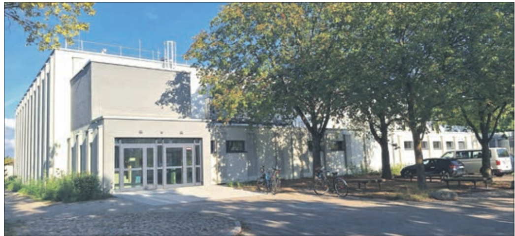
Die Sporthalle mit neuer Außenhülle, barrierefreiem Zugang und großer Lüftungsanlage. Foto: Hannelore Nowacki
